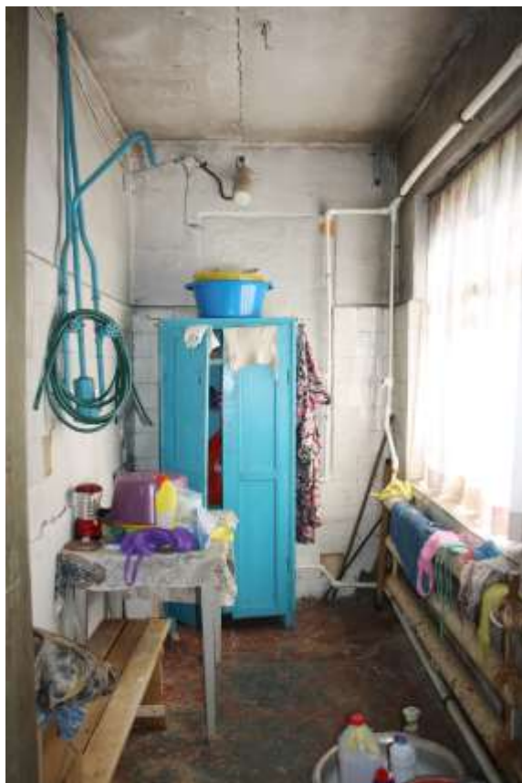
Фото №19. Помещение (№3 на п/п)
