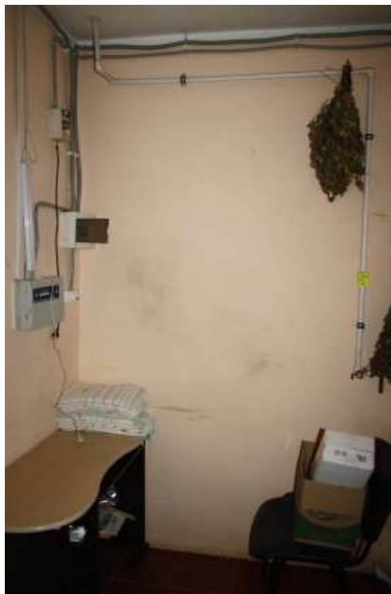
Фото №18. Помещение (№6 на п/п)
