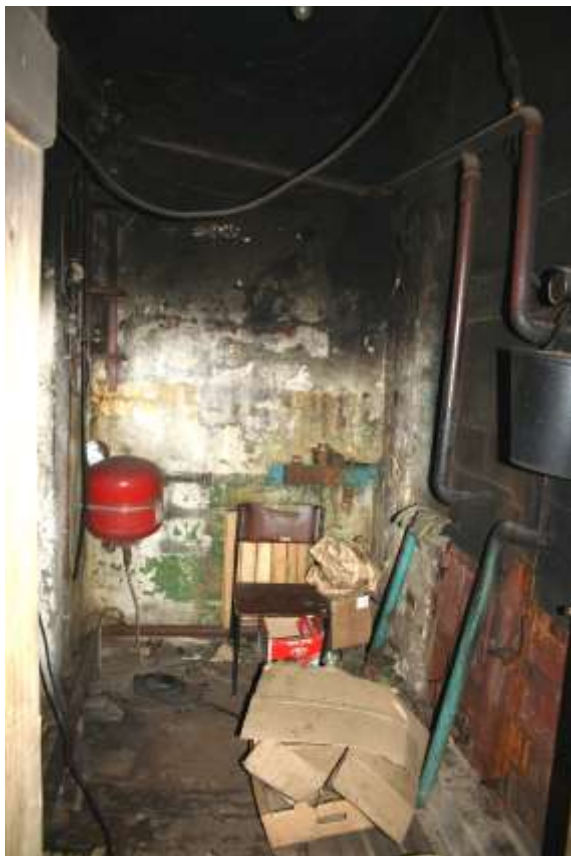
Фото №17. Помещение (№8 на п/п)
